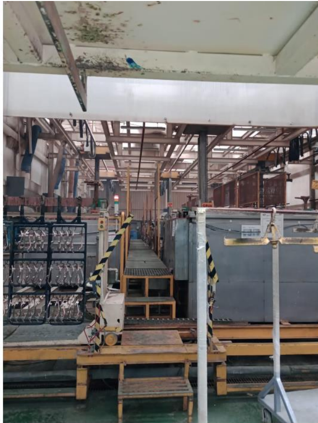
Figura 4.8 Área de producción del proceso de galvanizado
